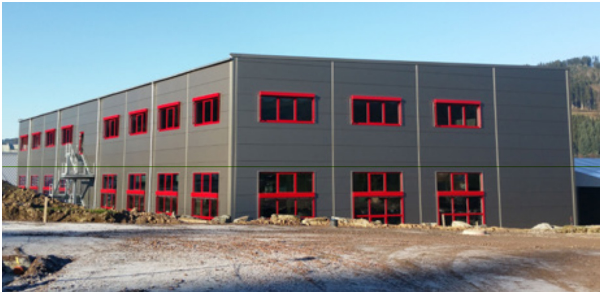
Der Neubau, mit dem Binder + Wöhrle seine Position am Markt halten bzw. ausbauen will.
