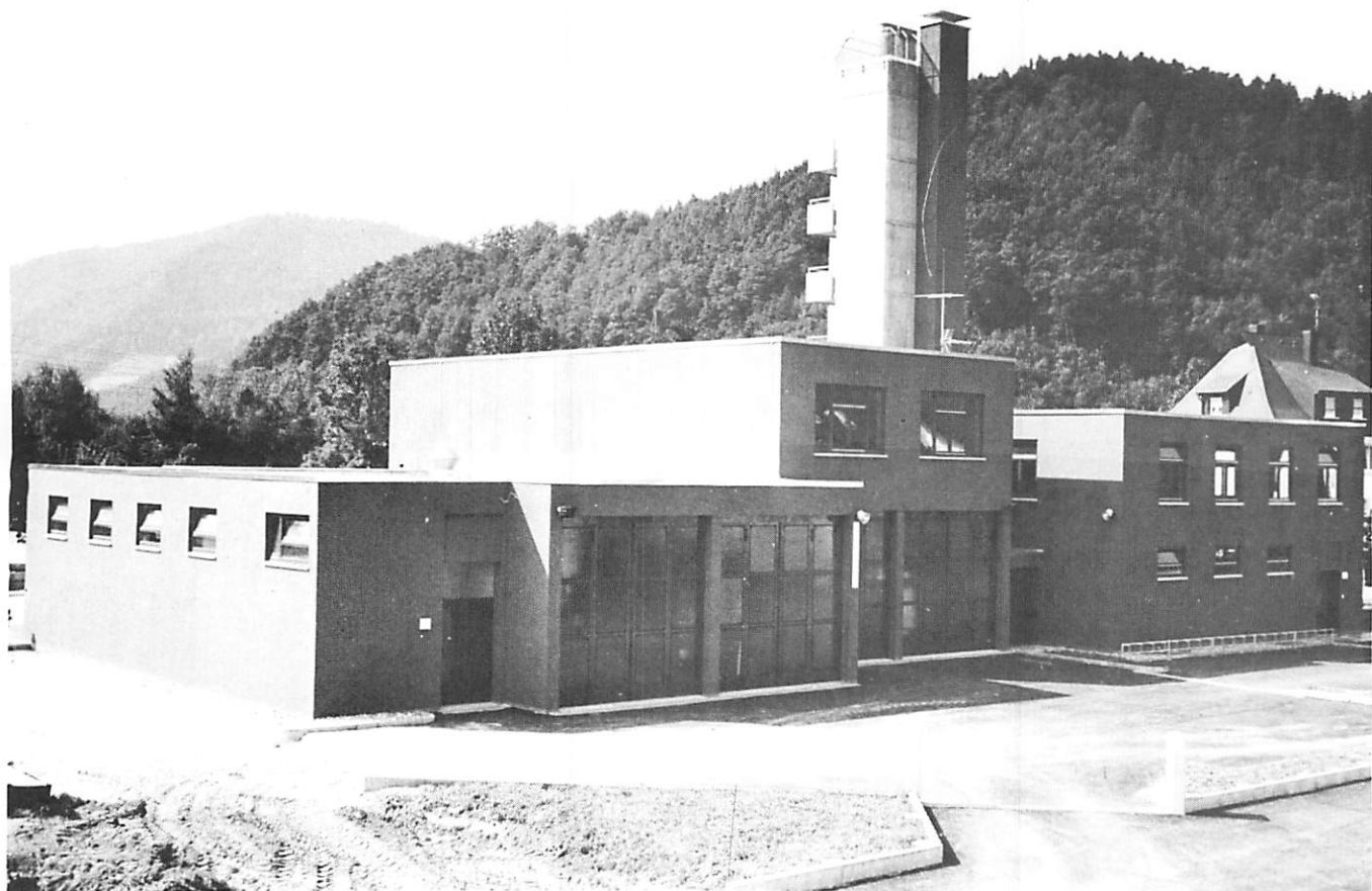
Das neue Feuerwehrgerätehaus wurde an der Einbacher Straße hinter dem "Schwarzwälder Hof" erstellt. (Foto-Goetze)
