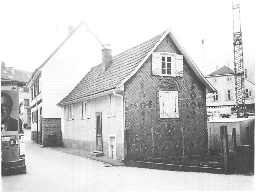
Das Haus Huhn, Am Gewerbekanal wurde im Jahre 1980 abgebrochen zur Anlegung von Stellplätzen, im Hintergrund die Baustelle für die Neubebauung des "Burgplatzes" (Foto-Goetze)
