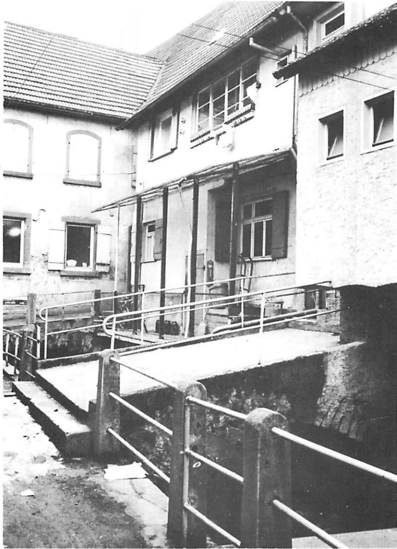
Blick zum "Grünen Baum" und Eisen-Schmid sowie "Traube" vor der Sanierung (Foto-Goetze)
