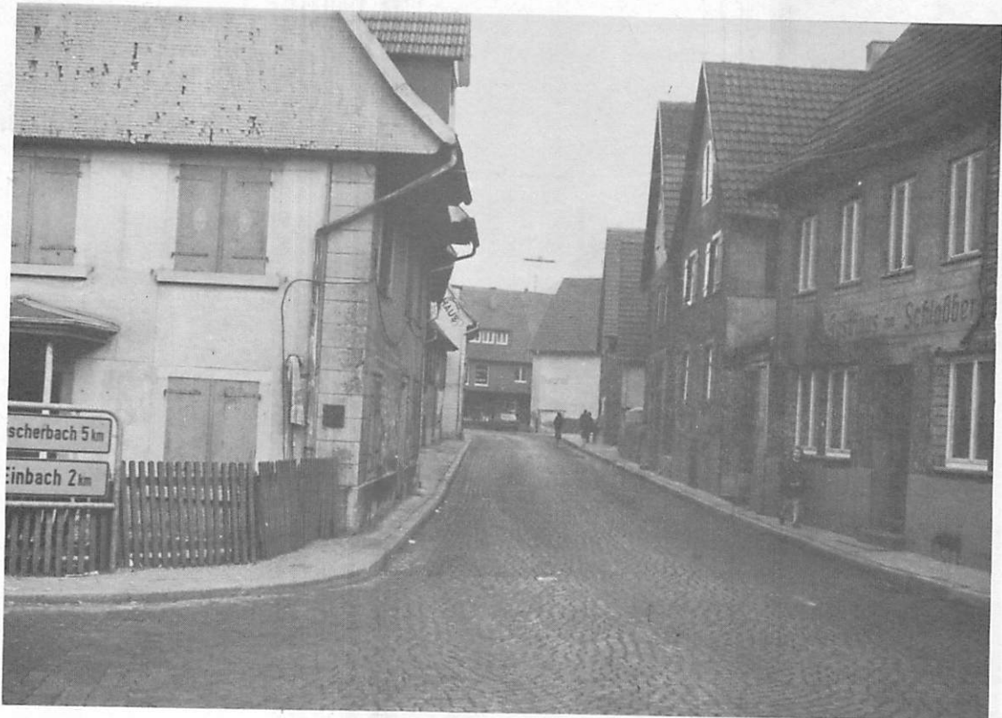
Blick in die sogenannte Engstelle vor der Sanierung (Foto-Goetze)
