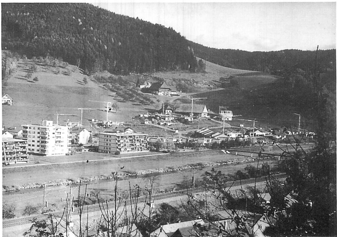
Im Baugebiet Hinterhof (Wintermaxenhof) ist eine rege Bautätigkeit zu verzeichnen. Rund 70 Häuser sollen hier entstehen.
