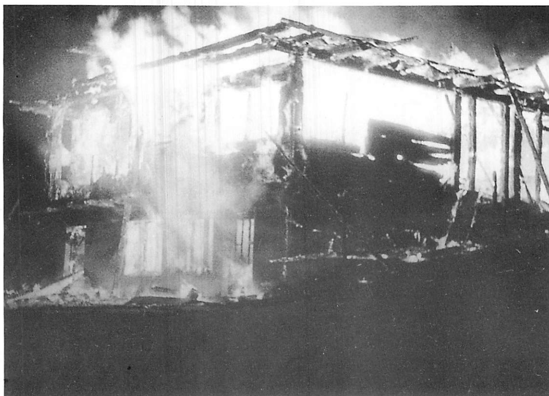
Durch Blitzschlag wurde das idyllisch gelegene Gebäude vernichtet.
