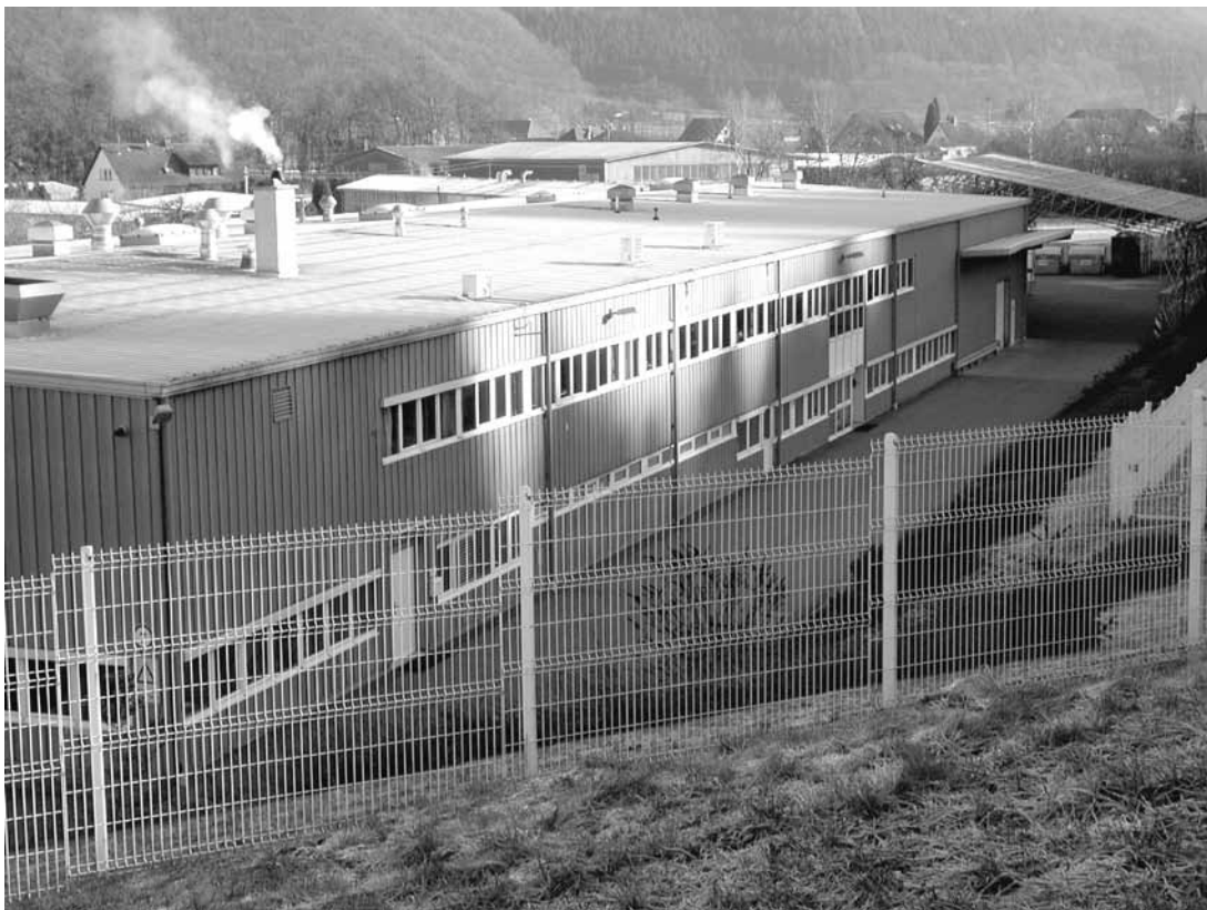
In dieser Halle begann die Firma Ditter mit der Produktion in Hausach
