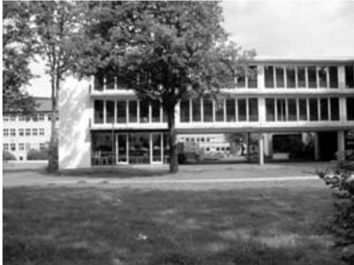
Blick auf die Kaufmännischen Schulen, das Robert-Gerwig-Gymnasium und dahinter die Graf-Heinrich-Schule. Im Vordergrund der neue Schul- und Stadthallenpark.
