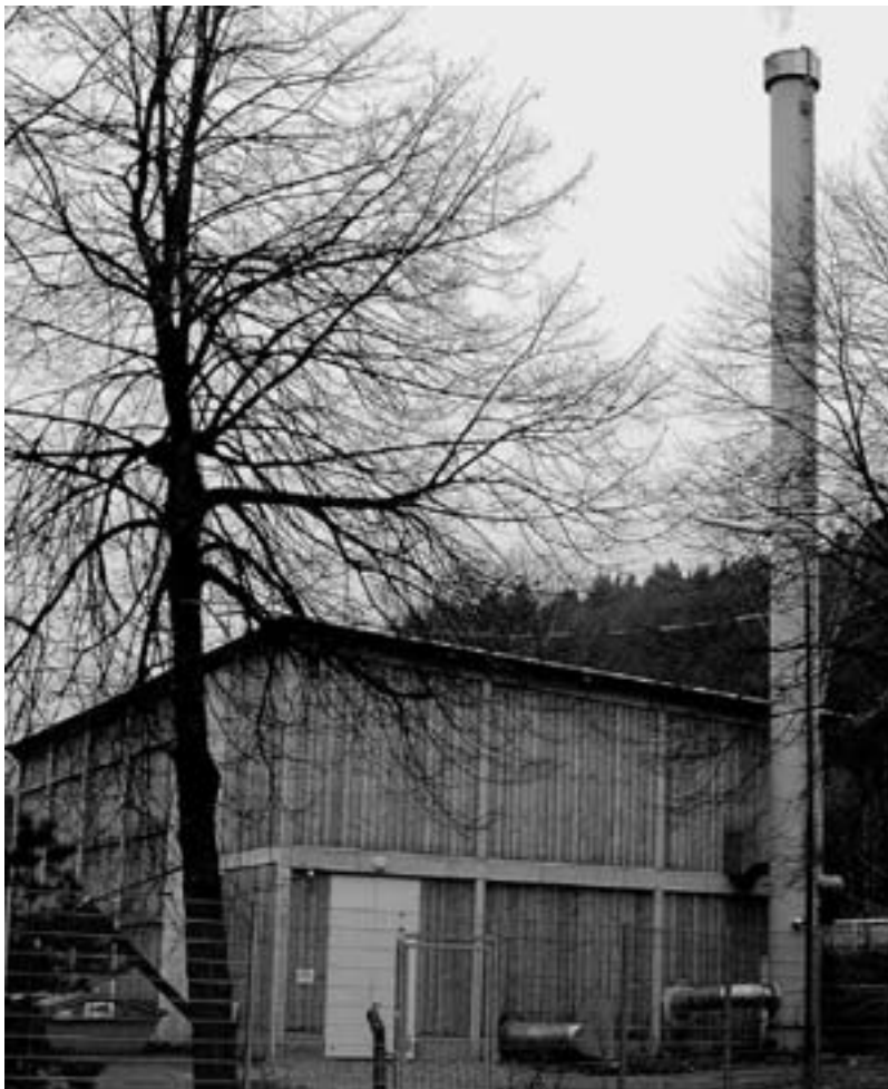
Die Nahwärmeversorgungsanlage im Bereich der Firma UCON.
