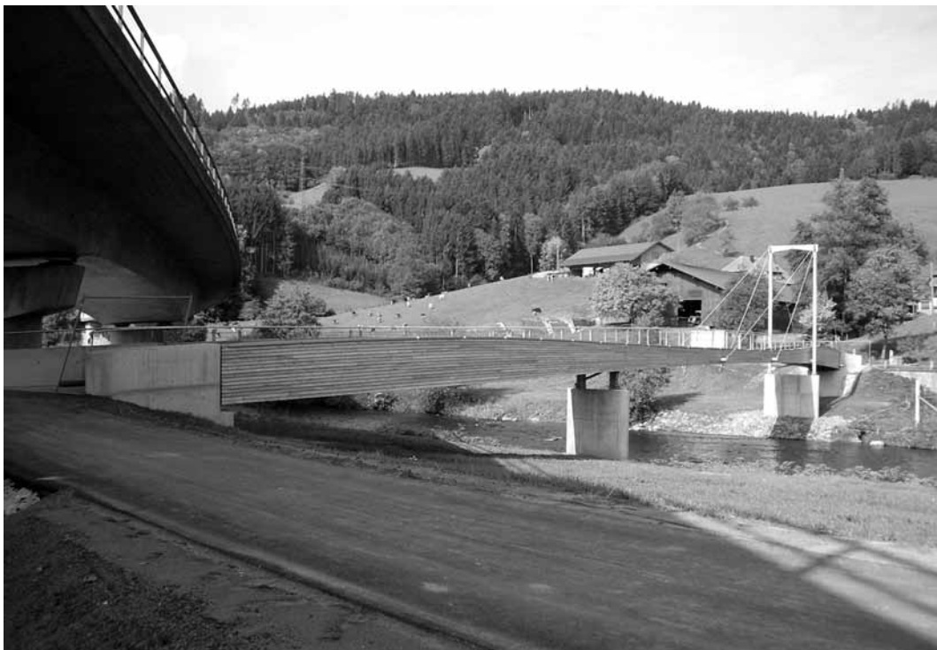
Die neue Brücke zur Frohnau
