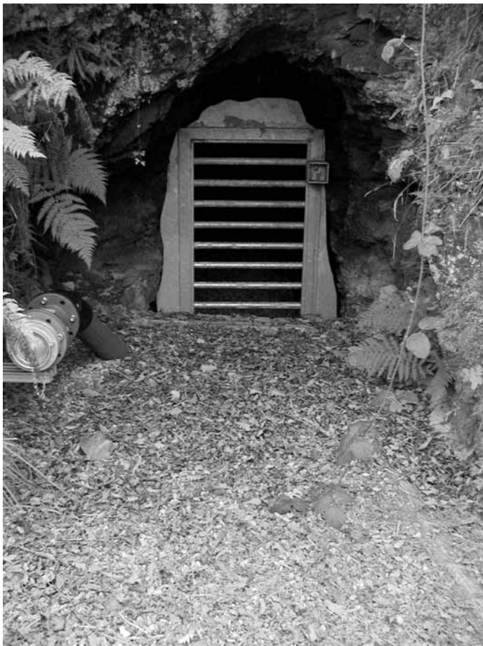
Der Stollenverschluss der Grube „Bernhard“ im Hauserbach mit dem Anschlussstutzen für die Feuerwehr
